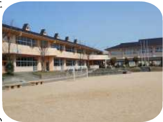
【改修工事が終わった校舎】
